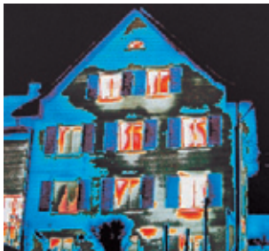
Herkömmliches Isolierglas: Rot bedeutet Energieverluste
